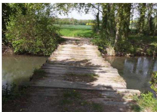
Photographie prise avant la réfection du pont à brebis
