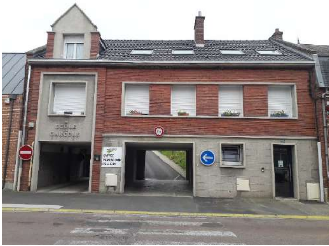
Immeuble rue Pellieux
